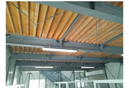
警察庁 青森県警察機動隊倉庫 (青森県) [室内天井]
