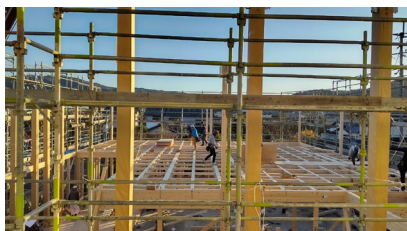
建設中の様子
